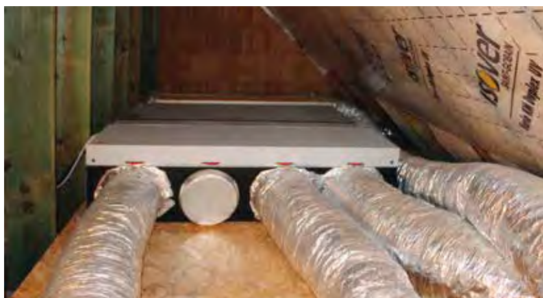
Het Shogun concept met individueel geregelde luchtverdeling naar de verschillende kamers.
