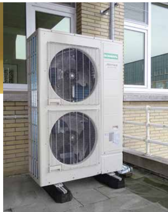
Airstage J4L, het VRF-systeem van General specifiek ontworpen voor toepassingen met 10 tot 42 binnentoestellen.
